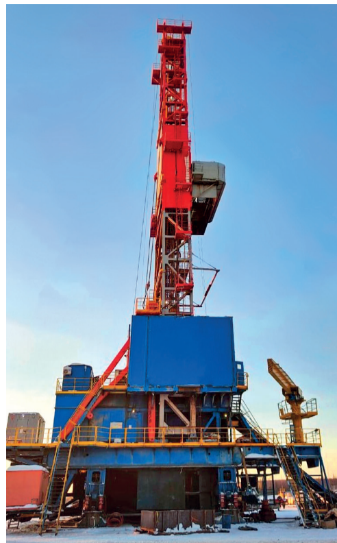
Буровая установка ООО «БНГРЭ» на КП-39
